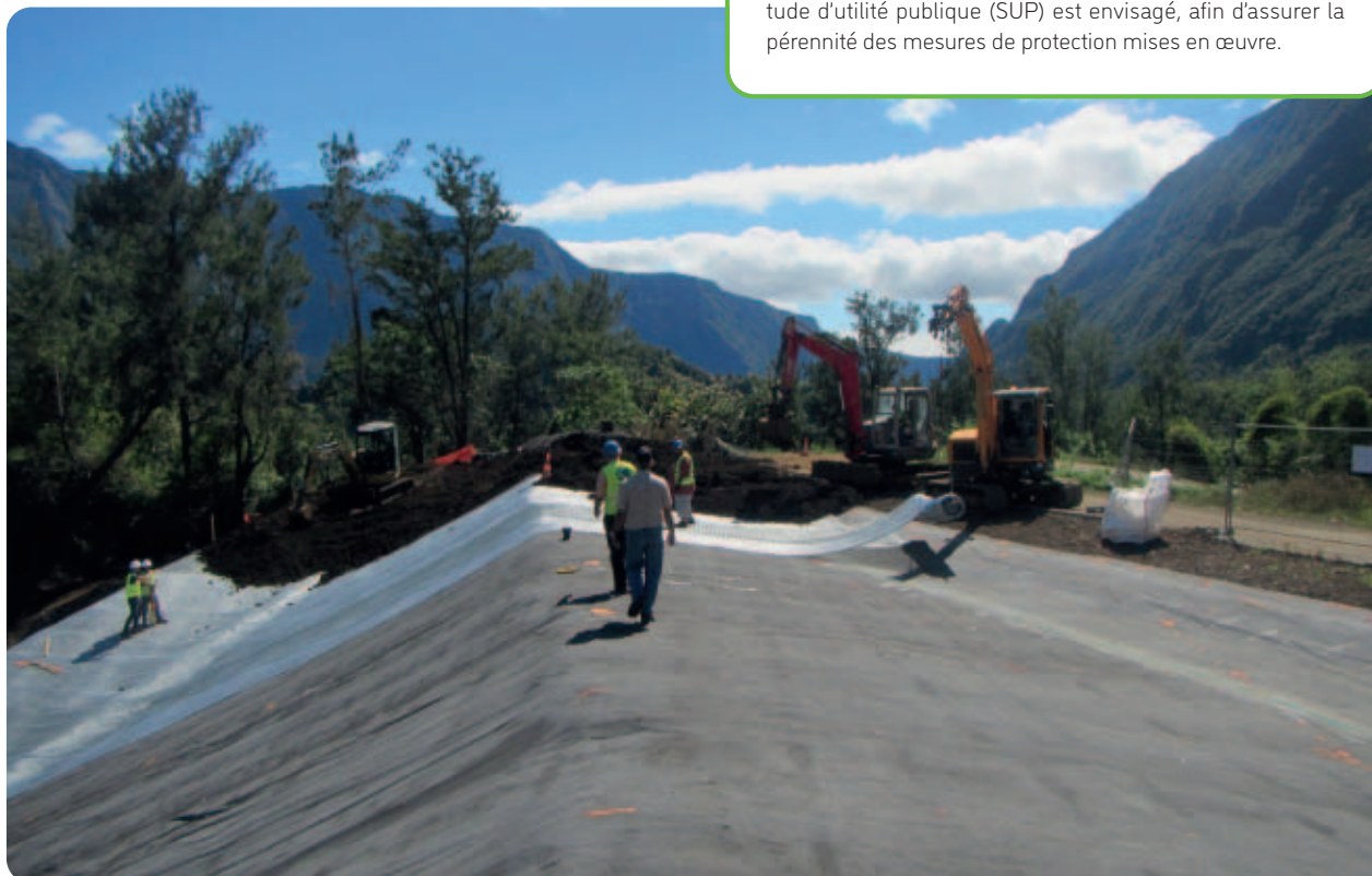
Géomembrane qui recouvre l'ancienne décharge de la Mare à Poule d'eau à Salazie
