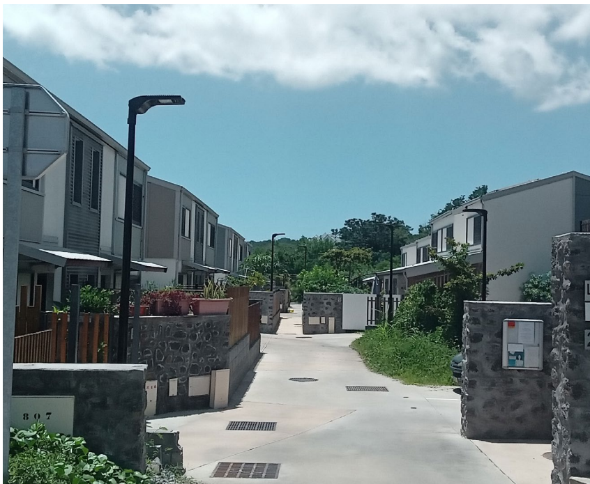
Les Sillages de l'ouest - La Possession - SEDRE
