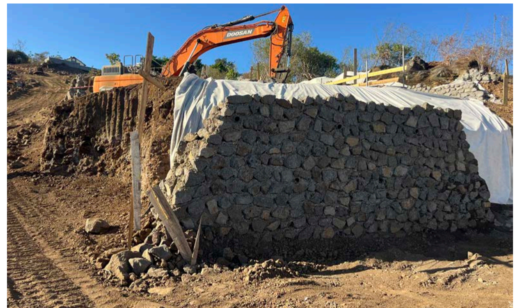
Construction des murets
