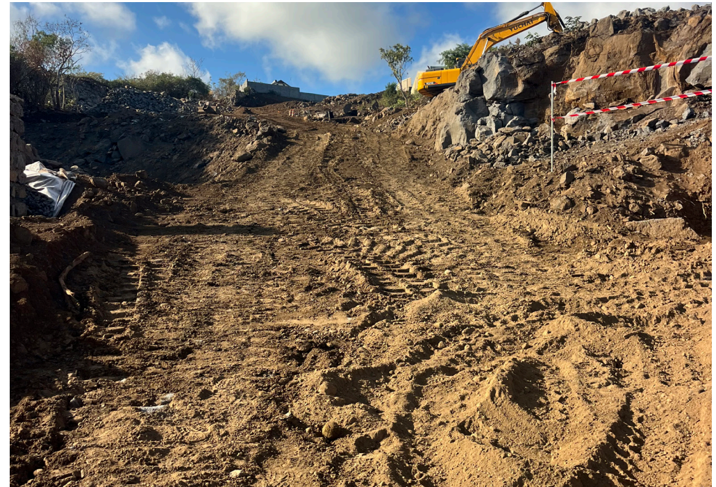
Terrassement en cours sur le projet de construction SHLMR
