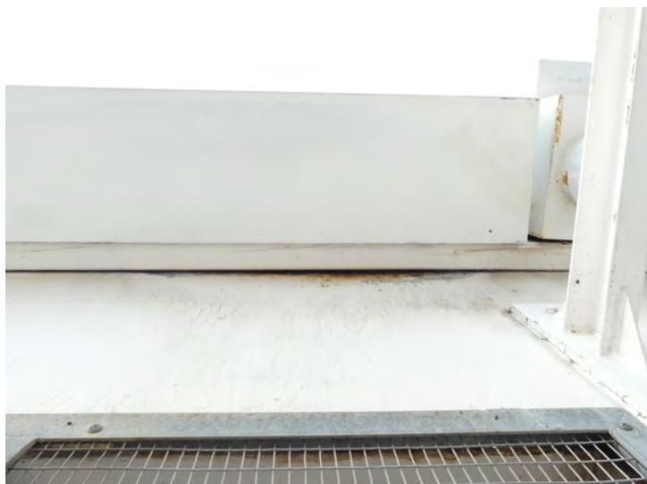
*Photo 10: exemple d'interstice à boucher avec installation d'un SAR*
