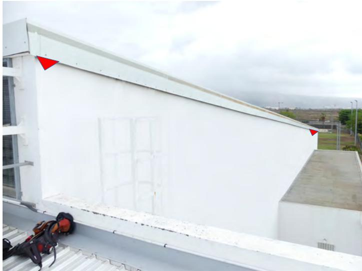
*Photo 9: positionnement des SAR sur le gîte en façade ouest*
