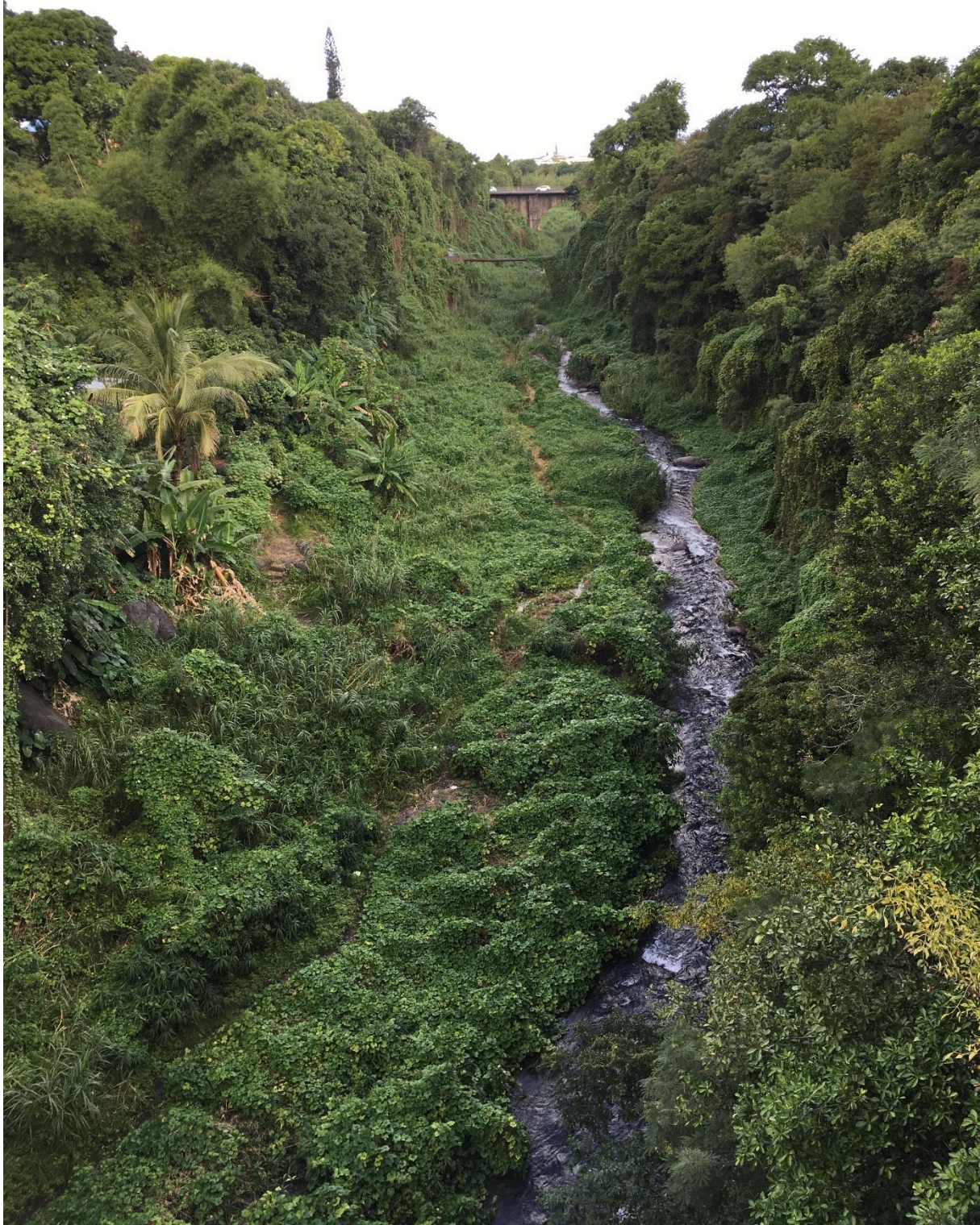
Vue sur l'aval du cours d'eau depuis le Pont de la RN1002
