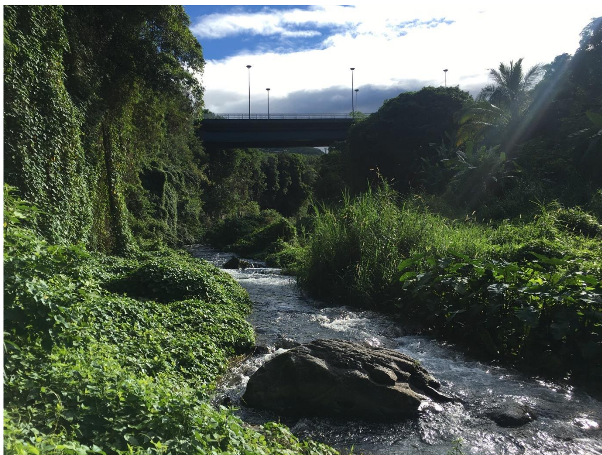
Vue sur le Pont de la RN1002 depuis le lit mineur du cours d'eau
