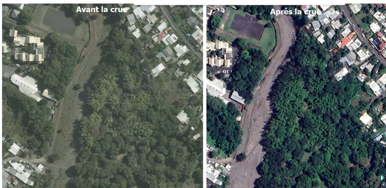
Figure 43 : Comparatif avant/après crue Garance (28 février 2025) – Grande Ravine des Lataniers : vues aériennes illustrant les impacts hydromorphologiques majeurs sur deux secteurs de la ravine
