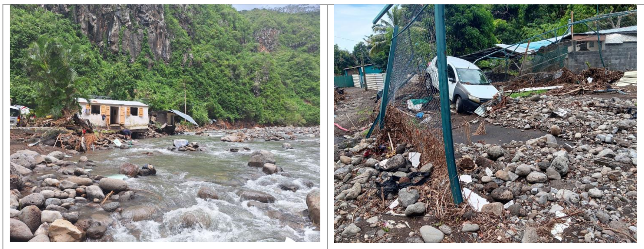
Figure 27 : Dommages causés par la crue lors de Garance en amont du hameau de la Colline (photos : CEREMA)
