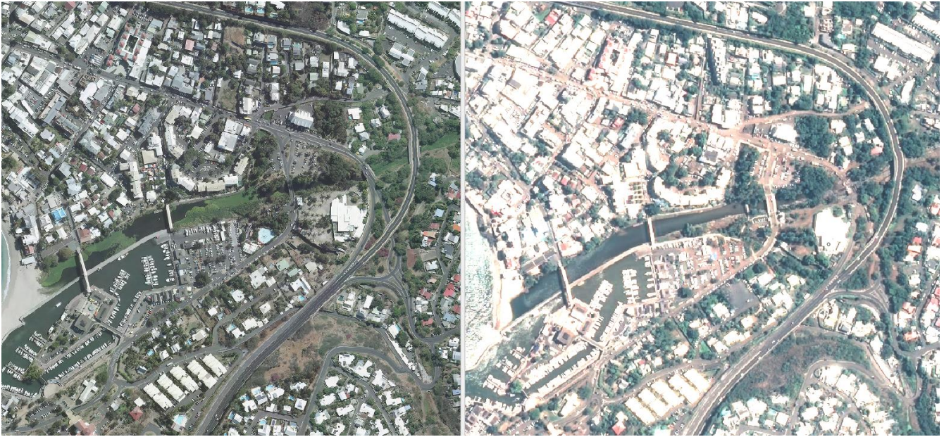
Figure 59 : Centre-ville de Saint-Gilles-les-Bains : images satellitaires avant et après la crue entraînée par le passage de Garance
