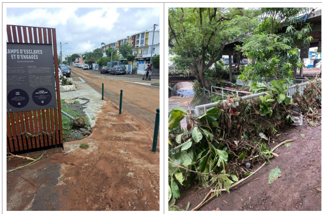
Figure 22 : À gauche, dépôts de boues et sédiments fins sur les trottoirs de l'avenue Hubert Delisle, au niveau de la confluence entre la ravine la Source et le ruisseau des Noirs, traduisant un débordement diffus dans la zone urbanisée. À droite, accumulation de flottants et de végétaux piégés contre les garde-corps au niveau du lavoir de la Source, témoignant d'une mise en charge importante de l'ouvrage et de l'intensité du flux (photos : DEAL 974).
