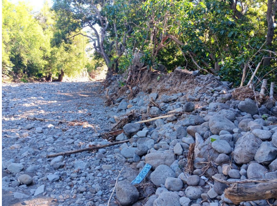
Figure 44 : Grande ravine des Lataniers : Extrusion latérale de blocs en rive droite en amont de la zone endiguée (photos : CEREMA).
