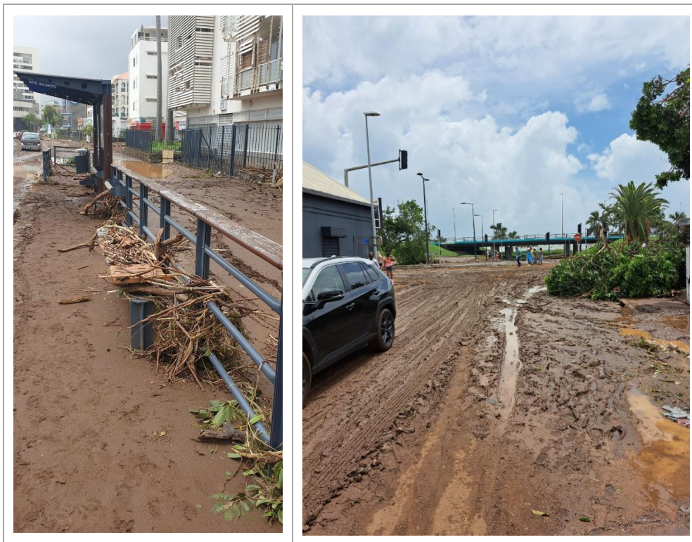
Figure 20 : Traces des débordements dans la partie aval de la ravine du Butor. À gauche, dépôt de boue fine sur la chaussée de l'avenue Maréchal de Lattre de Tassigny en rive droite, témoignant d'une submersion latérale étendue. À droite, dépôts de boue au niveau de la rue du Butor, en rive gauche (photos : DEAL 974).
