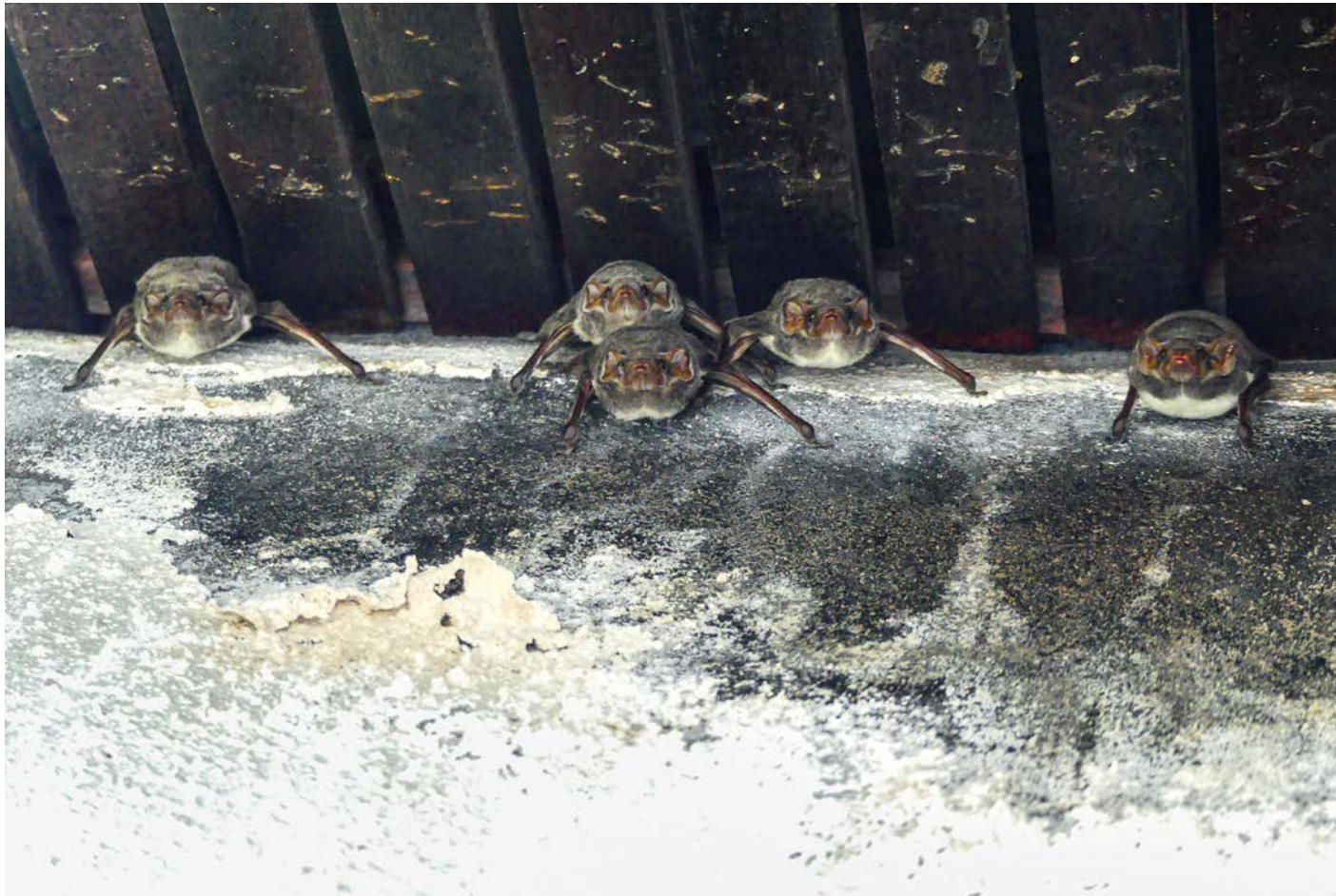
Taphiens de Maurice installés sous la corniche d'un toit. © Muriel Dietrich, UMR PIMIT
