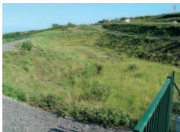
*Installation de bassins « multifonctions » permettant le traitement intégral des eaux collectées sur la plate-forme routière de la route des Tamarins (Saint Leu) avec : régulation des débits de fuite, décantation et piégeage sédimentaire, confinement en cas de pollution accidentelle.*
