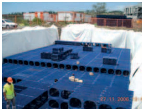
*Bassin de rétention/infiltration 910 m<sup>3</sup> en caisson, sur le lycée Saint-Paul 4 en 2006 (1<sup>re</sup> réalisation) BET exécution : C. REAT.E.UR*
