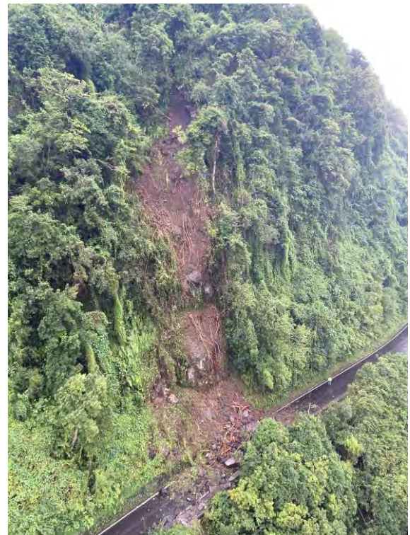
Figure 12 - A gauche : Chute de blocs ayant atteint la RD 48 (Route de Salazie) en 2019. A droite : Eboulement sur la RD 48 en 2021
