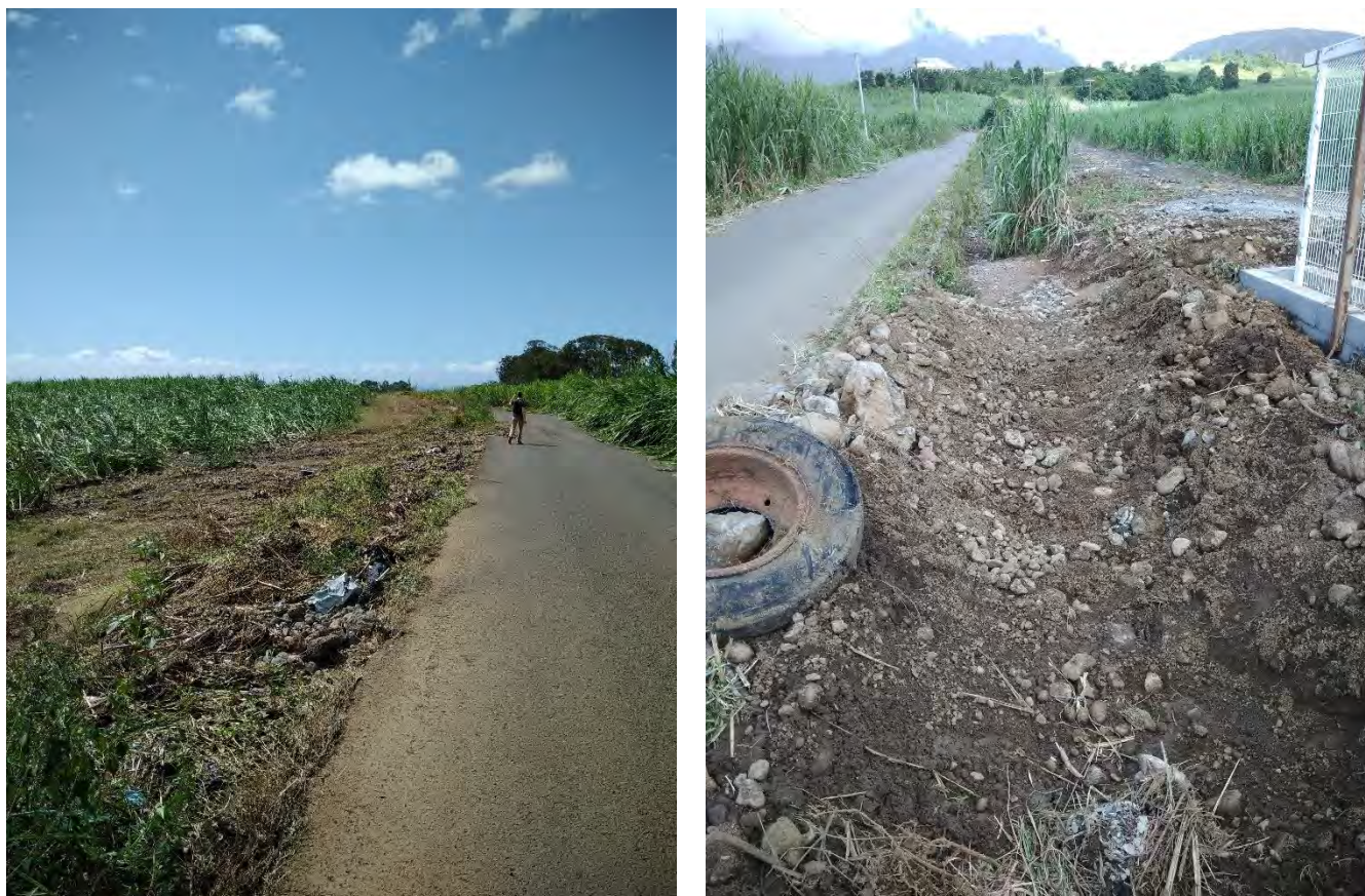
Figure 19 : Ravinement aux abords du chemin Dioré suite au passage de la forte tempête tropicale Fakir (2018).
