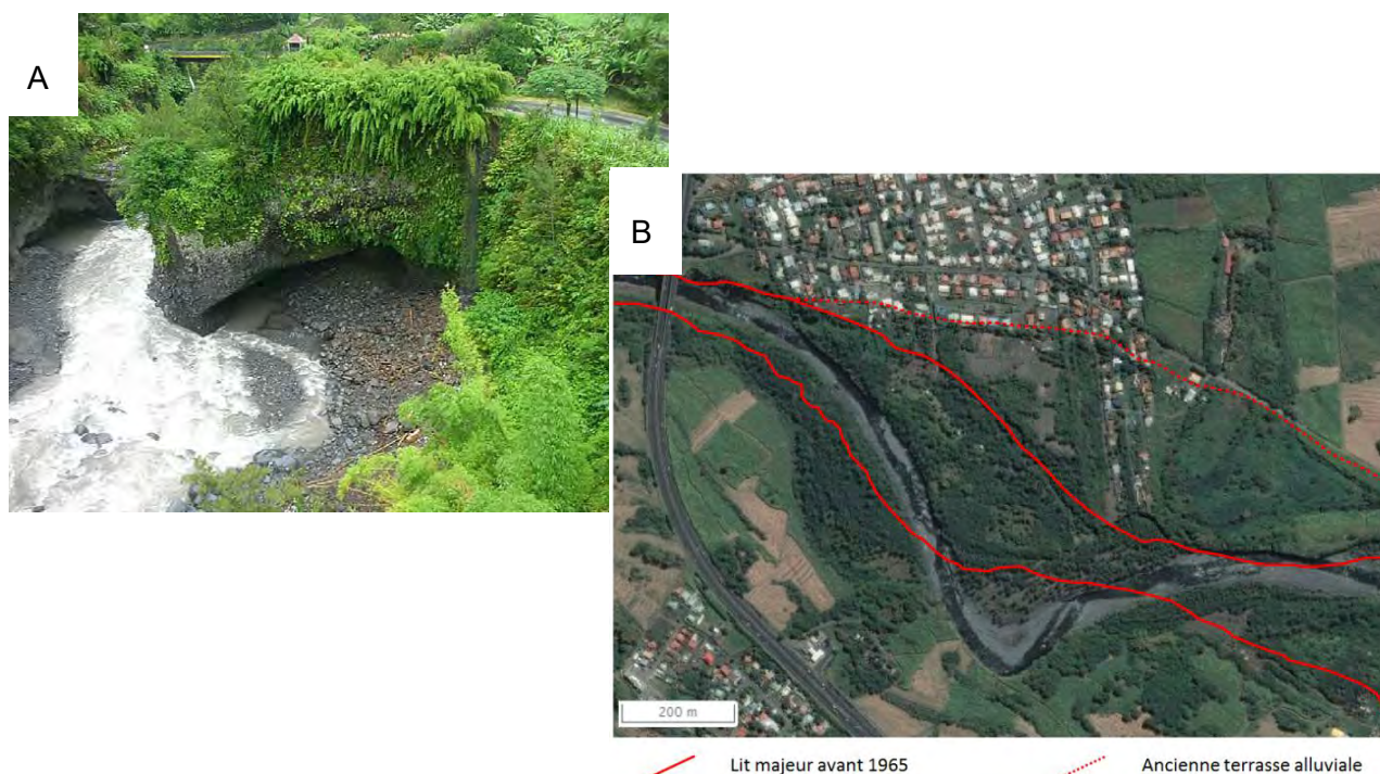
Figure 16 : A. Erosion de berge localisée peu avant le pont de l'Escalier à la limite communale entre Saint-André et Salazie. B. Photo aérienne montrant le lit majeur actuel de la Rivière du Mât auquel a été surimposé le lit majeur avant 1965 (par photos aériennes anciennes). On voit bien l'évolution rapide du tracé des berges et les habitations potentiellement concernées.
