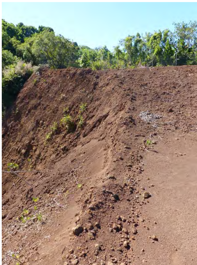
Figure 15 : Glissement de terrain sur une parcelle terrassée à Dioré, 2018.
