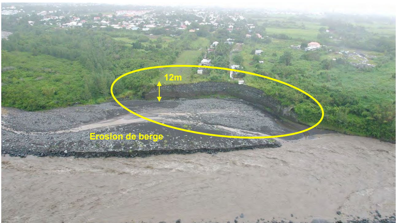
Figure 18 : Lit de la rivière du Mât et berge en rive gauche durant le passage du cyclone Gamède (2007).
