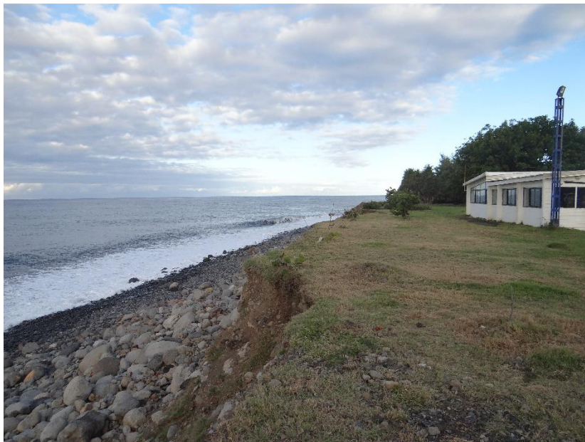
Figure 22 : Erosion du haut de plage derrière le restaurant Le Beau Rivage (Campagne OBSCOT, 2018)
