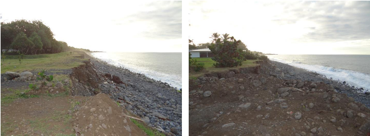
Figure 5 : A gauche : Photo de l'érosion du haut de plage au niveau du quartier de Champ-Borne ; A droite : Photo de l'opération de remblaiement effectuée par la commune aux abords du restaurant « Beau Rivage ».
