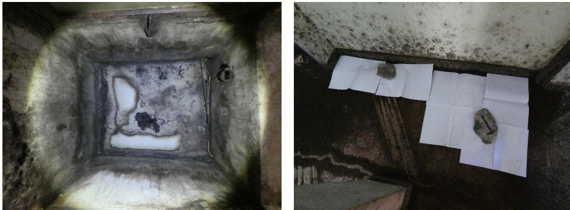
Figure 19 : Inspection visuelle directe de la zone principalement occupée et suivi qualitatif de l'évolution des dépôts de fèces
