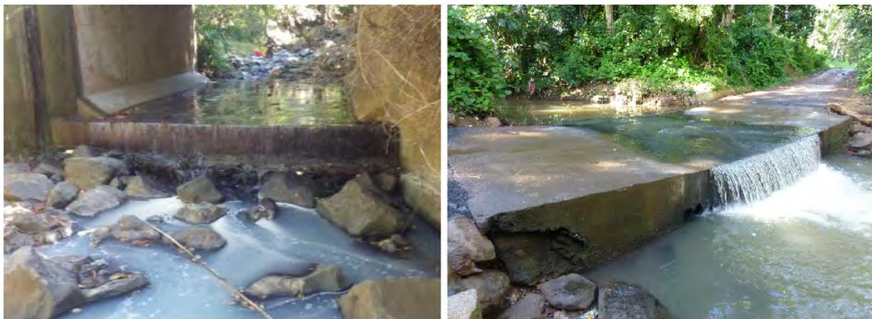
Figure 30: Exemples d'un pont "cadre" (gauche) et d'un franchissement de type "passage à gué" (droite) créant des obstacles à la continuité biologique sur les cours d'eau de Mayotte
