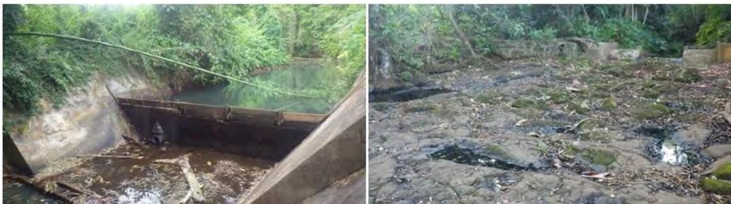
Figure 31: Exemples de captages d'eau de surface induisant une forte diminution de la surface mouillée en aval, voire un assec (OCEA, 2017 et 2012)
