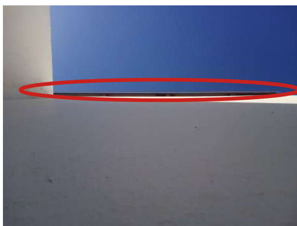
Photo 2: Rive utilisée par les chauve-souris (traces d'urine + suintement)
