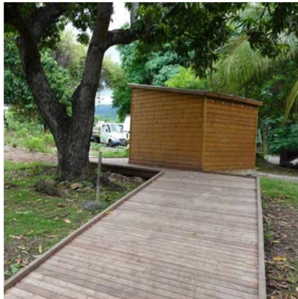
Réhabilitation du platelage bois exotique
