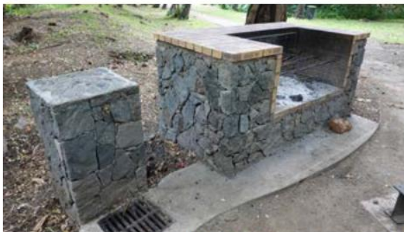
Réalisation d'un barbecue et d'une borne fontaine
