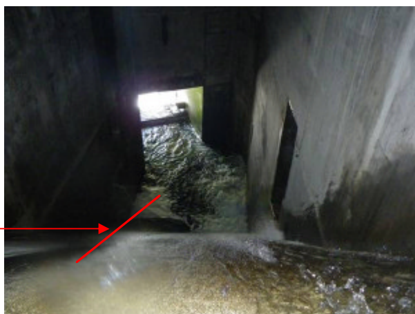
Vue des voies de passage au niveau de la rampe de franchissement. Prise ILO de la rivière des Fleurs jaunes (Source : ARDA-ONEMA-ECOGEA, 2009)
