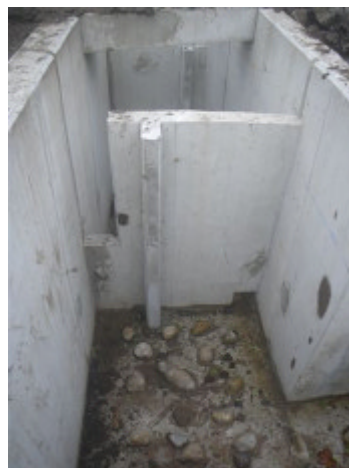
Passé à échancrure latérale et orifice de fond avec rugosités en fond (exemple : Bliesschweyen sur la Blies)
