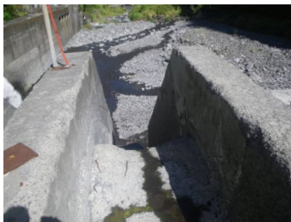
La passe à cabots bouche-ronde implantée sur le seuil de prise d’eau SAPHIR du Bras de la Plaine. La prise d’eau du dispositif est totalement obstruée par un dépôt de sédiment. La passe n’est plus alimentée
