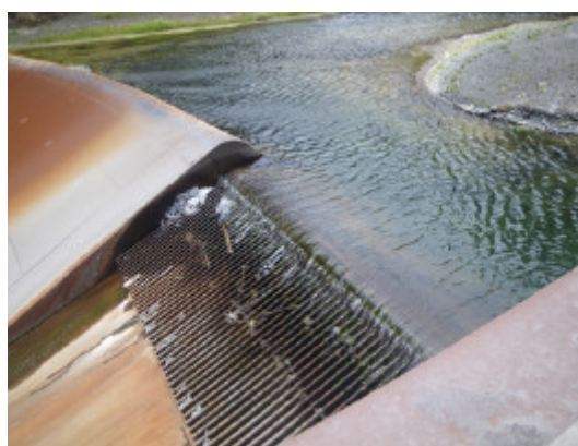
Prise d'eau dite "en dessous" située sur le seuil ILO de la rivière des galets
