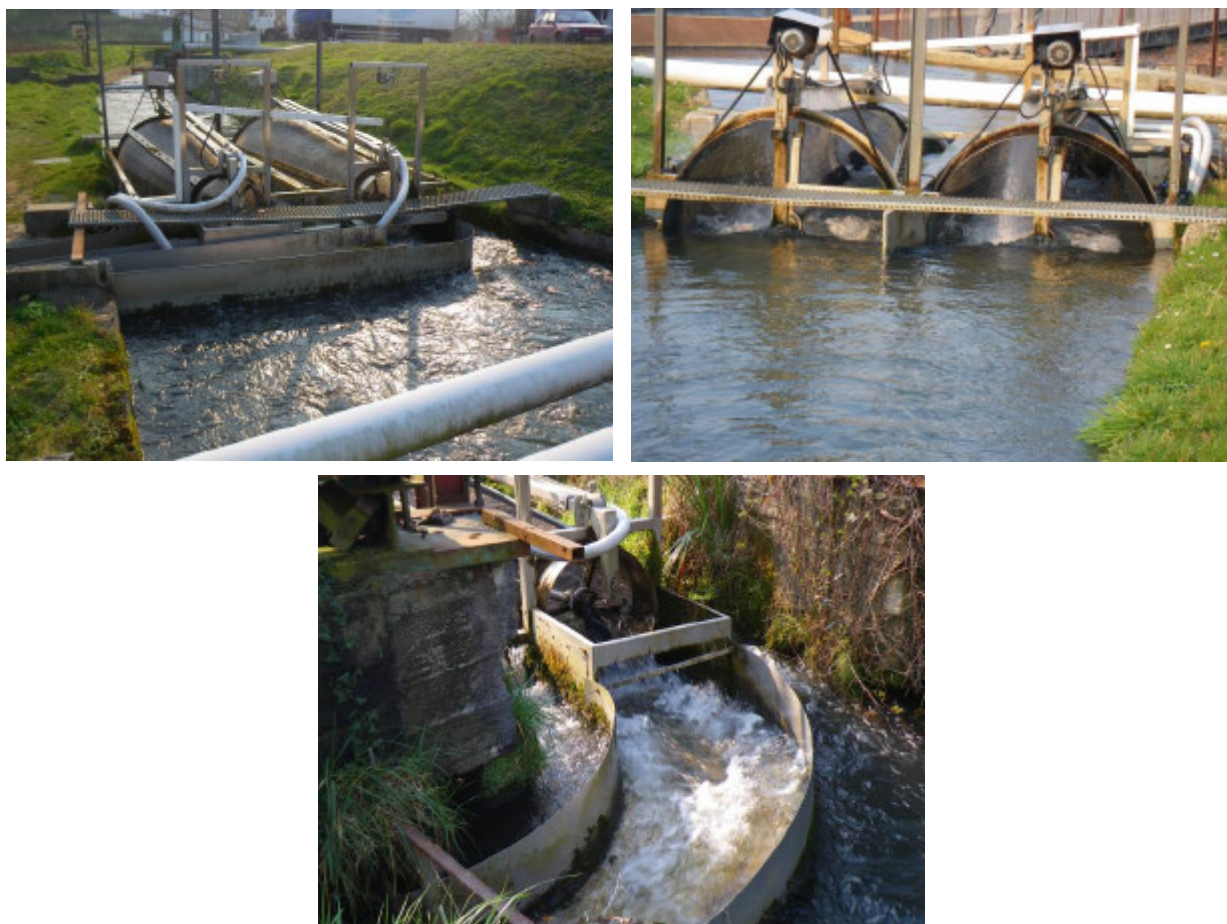
Effeilleuses rotatives de type Erm installées au niveau de piscicultures sur la Nive (64)
