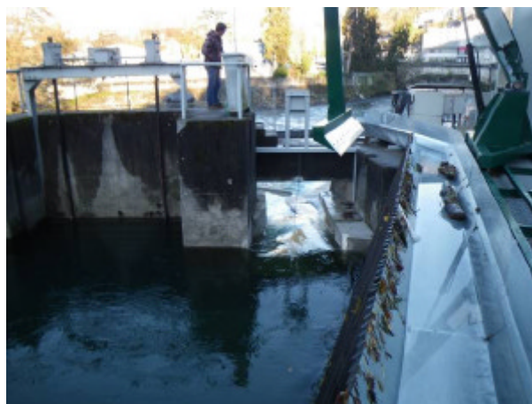
Exutoire de surface installée latéralement au plan de grille. Type d'exutoire adapté pour des plans de grille inclinés latéralement par rapport aux écoulements (Photo : Usine de La Grotte sur le gave de Pau ; Schéma : Courret et Larinier, 2008)
