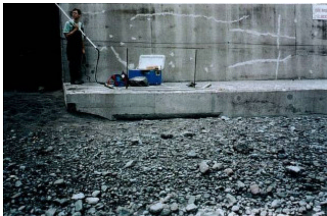
Passé à cabots bouche-rondes située sur la rivière des galets. Vue de la prise d’eau de la passe colmatée après une crue
