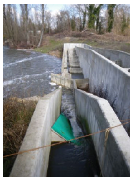
Exemple de passe à bassins équipée en parallèle d’une passe spécifique pour les civelles (photo : passes de Montfourat sur la Dronne)
