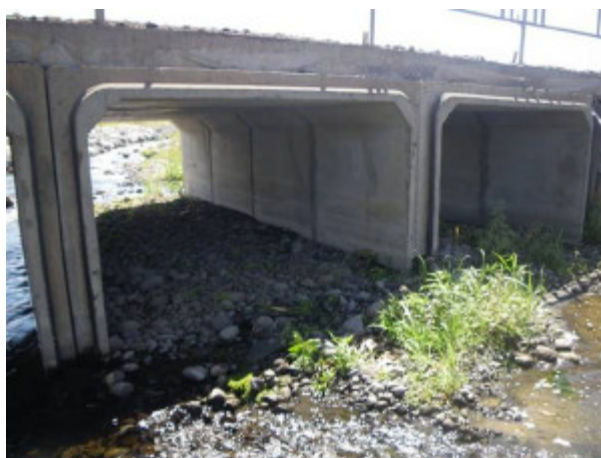
Dépôt de sédiments dans les dalots extérieurs permettant d’offrir quel que soit l’hydrologie, une zone propice pour le franchissement des espèces (Exemple : Riv Ste Etienne)
