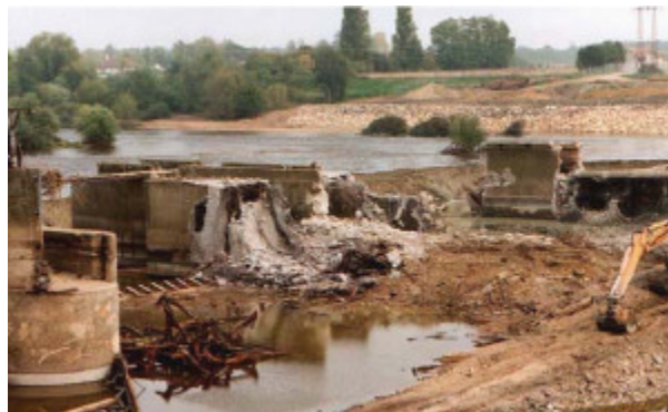
Travaux d’effacement en cours
