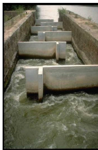
Passe à échancrure latérale avec orifice de fond
