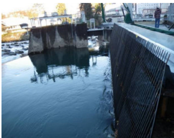
Plan de grille incliné latéralement au sens de l’écoulement, installé à l’usine hydroélectrique de La Grotte à Lourdes (Gave de Pau). Espacement entre barreaux = 2 cm
