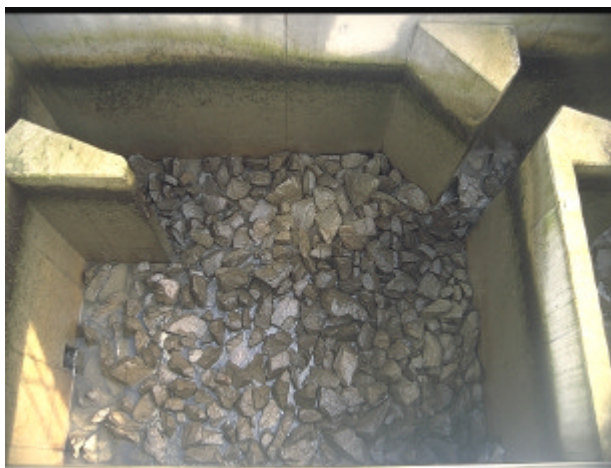
Passé à fente avec rugosités en fond (exemple : Iffezheim sur le Rhin)
