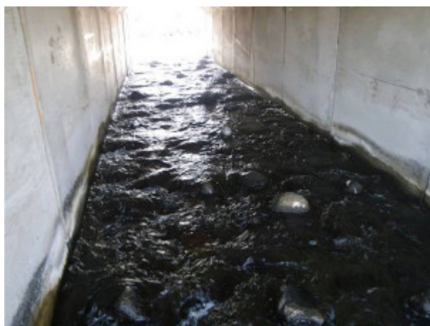
Exemples de dalots ancrés dans le lit du cours d’eau (Riv Ste Etienne)
