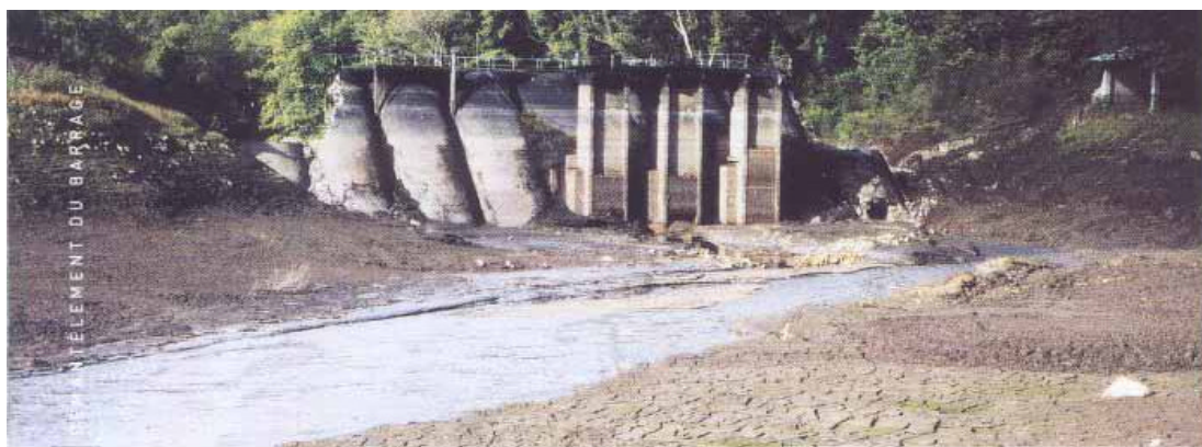
Vue de l’ancienne retenue après vidange et du barrage de Kernansquillec sur le Léguer en cours de démolition (Source : brochure du Ministère de l’écologie et du développement durable)
