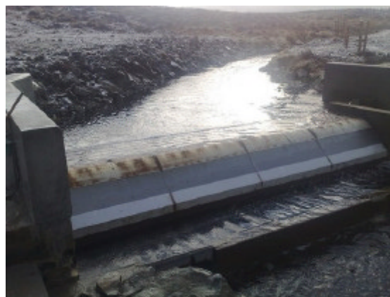
Exemples de prises d’eau AquaShear © Coanda installés en Europe du Nord par Dulas
