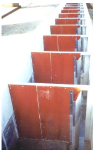
Exemple de passe à fente verticale installée en Australie (chute de l’ordre de 10 cm et puissance dissipée de l’ordre de 50 W/m3)
