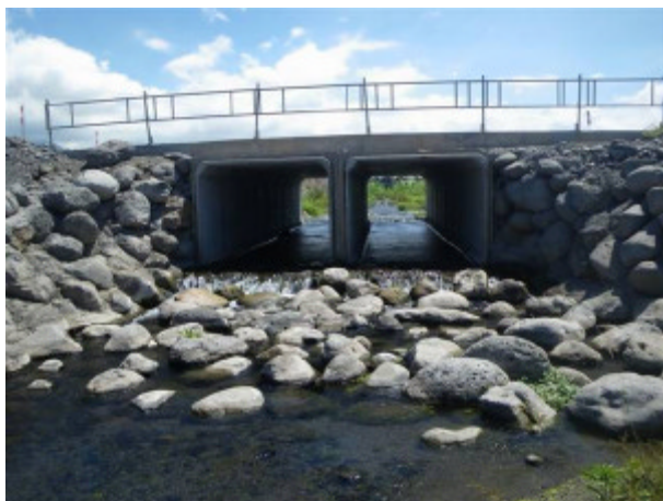
Chute problématique en aval de buse ou dalot (exemples : Riv des Pluies et Riv. Ste Etienne)
