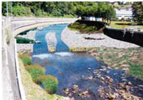
Photo après travaux (source : Biotec, Malavoi)
