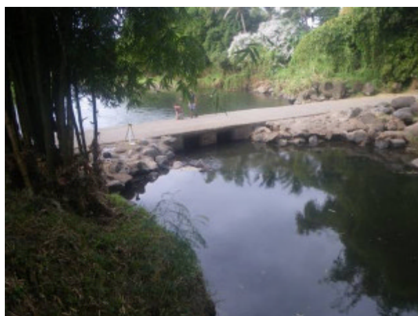
Mauvais : Passage busé 5 fois moins large que la largeur du lit du cours d’eau (exemple : ouvrage routier sur la riv. Ste Suzanne)
