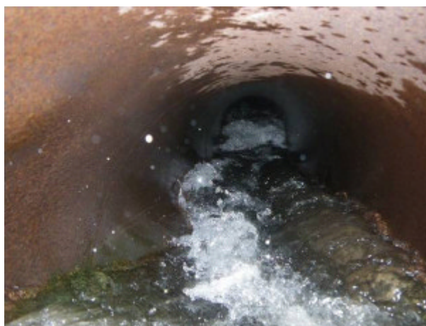
Fortes vitesses d’écoulement dans une buse de la piste des carriers (Riv Ste Etienne)
