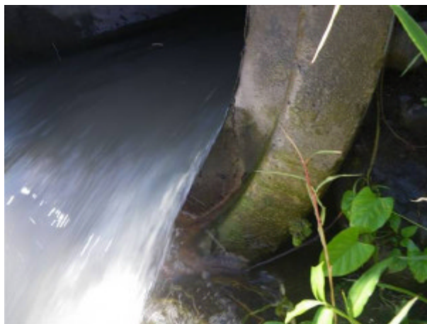
Décollement de la lame d’eau et zone difficilement franchissable pour les gobiidés, civelles et macrocrustacés
