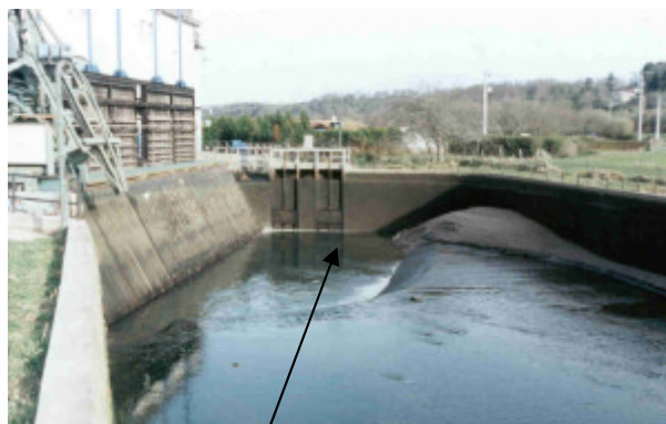
Exutoire de surface installée latéralement au plan de grille. Type d'exutoire adapté pour des plans de grille inclinés latéralement par rapport aux écoulements (Photo : Usine de La Grotte sur le gave de Pau ; Schéma : Courret et Larinier, 2008)
