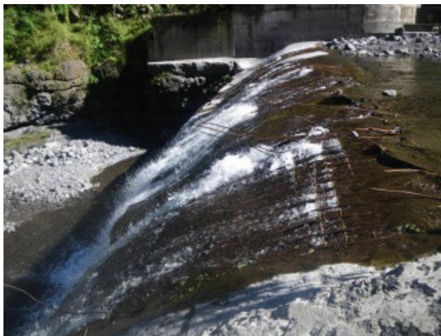
Etat du contre barrage de la prise d’eau SAPHIR du Bras de la Plaine. La mise à nu des ferailles montre l’importance du transport solide et les fortes contraintes abrasives subies par certains ouvrages.
