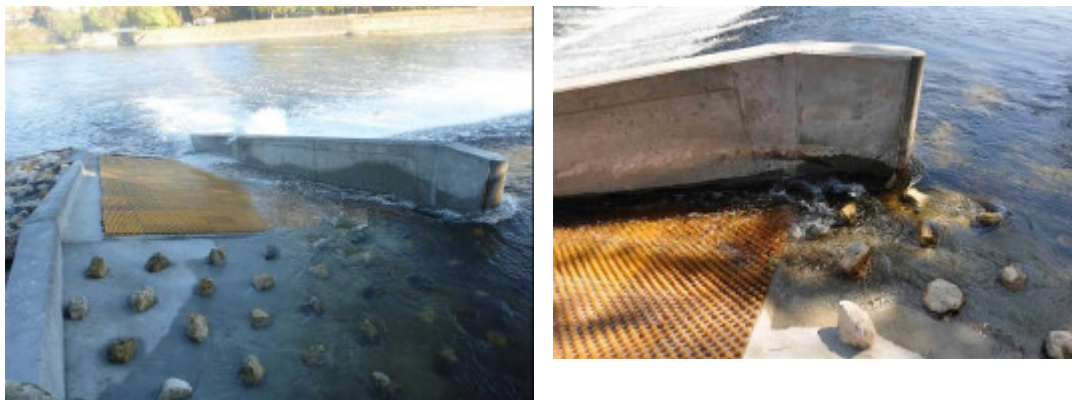
Substrat en polyuréthane installé sur la passe de Bergerac sur la Dordogne
