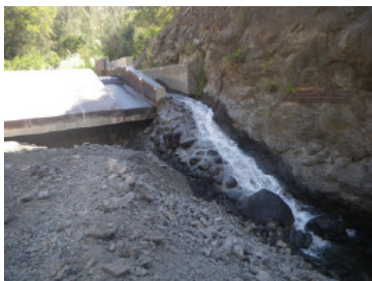
Passe en enrochements liaisonnés installée sur le Petit Bras de Cilaos. Ce type de substrat est peu adapté au franchissement des anguillettes.
