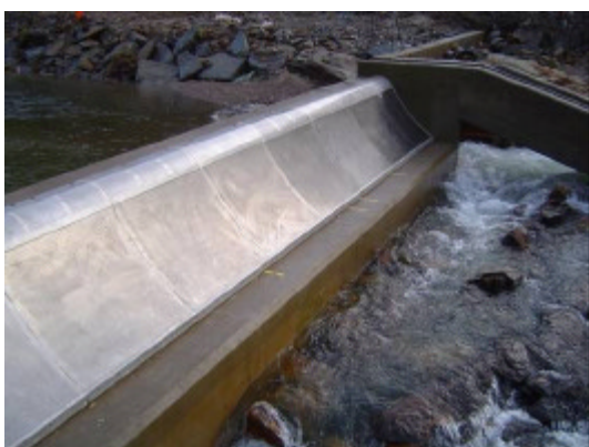
Exemples de prises d’eau AquaShear © Coanda installés en Europe du Nord par Dulas
