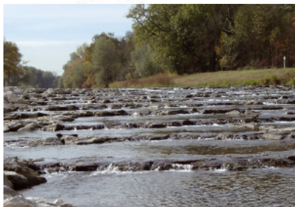
Passé à rangées périodiques présentant des fentes. Ce principe est plus adapté aux espèces à faibles capacités de franchissement qui peuvent ainsi passer au fond (exemple de Kolbermoor en Bavière)
