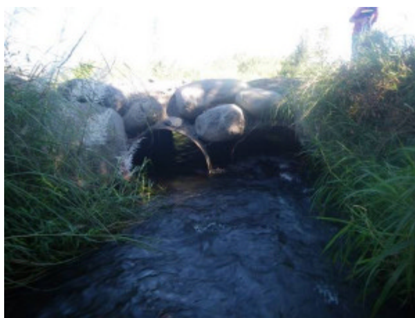
Bon : La largeur des passages busés est bien adaptée par rapport à la largeur du lit (exemple : Passage busé de la piste des carriers sur la riv. Ste Etienne)
