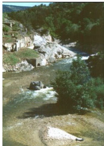
Photo après travaux : SOS Loire Vivante
