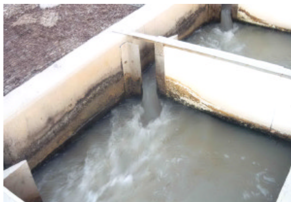
Exemple de passe à fente verticale installée en Australie (chute de l’ordre de 10 cm et puissance dissipée de l’ordre de 50 W/m3)
