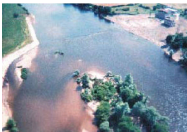
Le site après travaux
