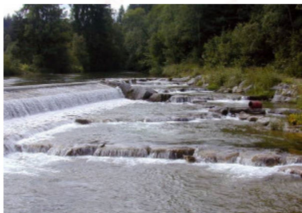
Passé à rangées périodiques ne présentant pas de pelles au niveau des seuils (exemple de Leitner en Bavière)
