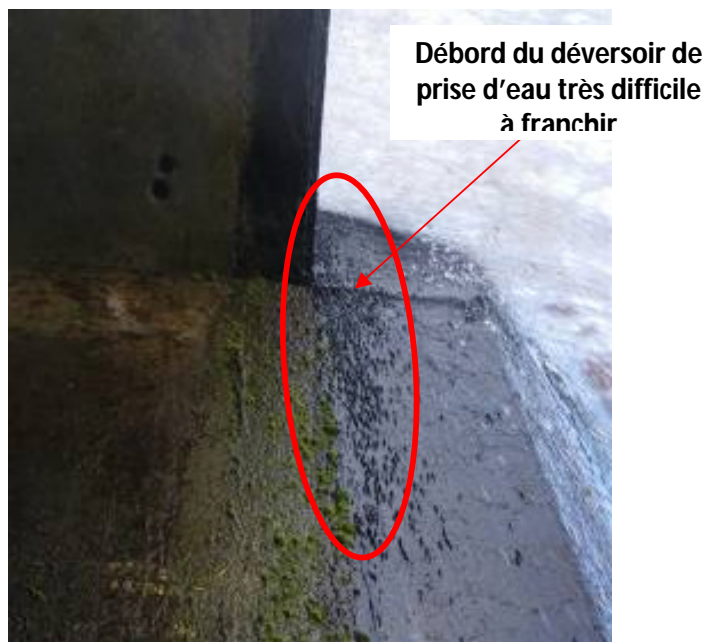
Observations visuelles sur la prise de la rivière du Mât, voies de franchissement observées. 1 : parement aval, 2 : entrée de la passe à bichiques (source : ARDA-ONEMA-ECOGEA, 2009)
