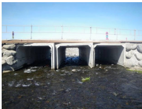
Exemples de dalots ancrés dans le lit du cours d’eau (Riv Ste Etienne)
