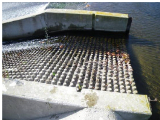
Substrat Evergreen installé sur le seuil d’Halsou sur la Nive
