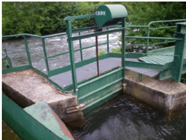
Exutoire de dévalaison de Crampagna (Ariège) équipé d’un système d’éclairage (lampe à vapeur de mercure).
