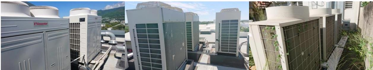
Figure 21 – Quelques clichés de groupes VRV équipant les sites de l'échantillon
