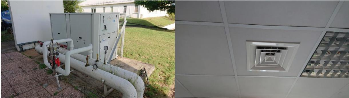
Figure 32 – Aperçu du GEG (à gauche) et d'un émetteur associé (à droite)
