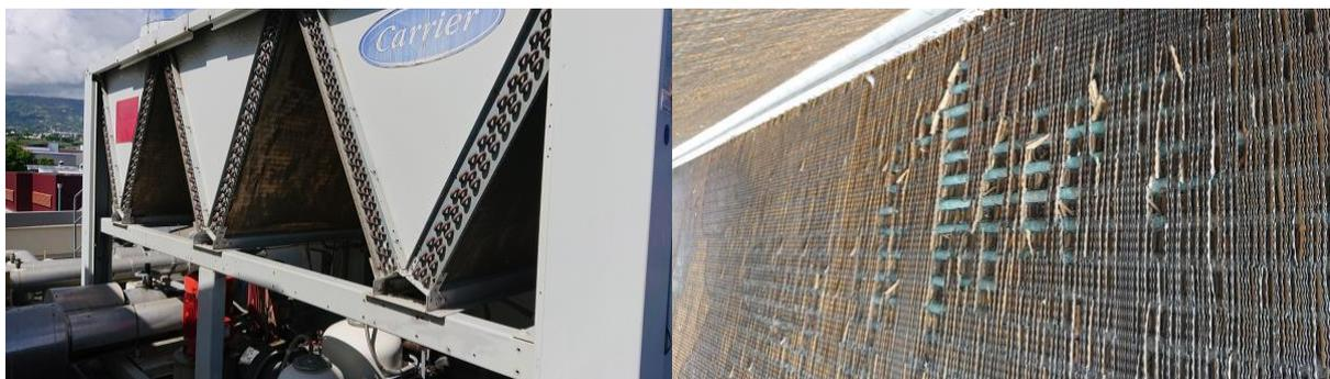
Figure 22 – Zoom sur le condenseur du GEG B
