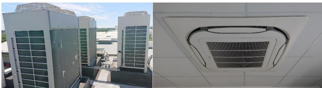
Figure 38 – Aperçu des groupes VRV (à gauche) et émetteurs associés (à droite)
