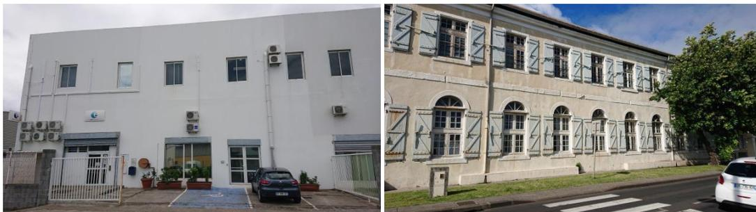
Figure 14 – Aperçu de façades dénuées de protections solaires
