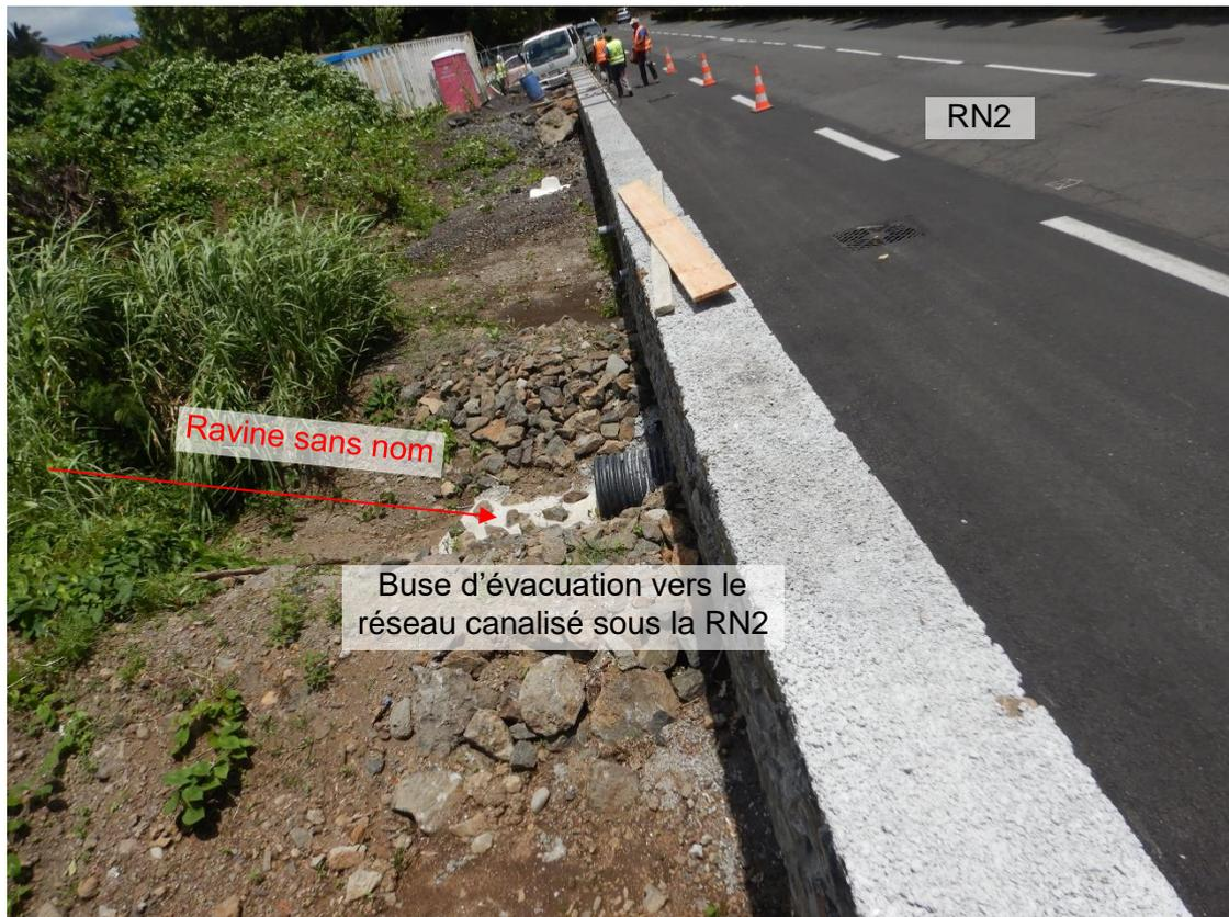
Figure 10 : Buse d'évacuation de la ravine sans nom sous la RN2
